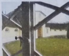
Das Kulturdenkmal muss auch innen umfangreich saniert werden
